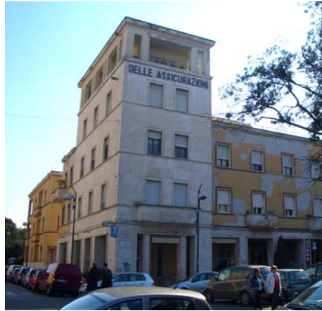
Fig. 8. Piazza della Libertà - Palazzo INA Corpo A
