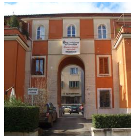
Fig. 1. Edificio civile abitazione, veduta da piazza del Popolo.
