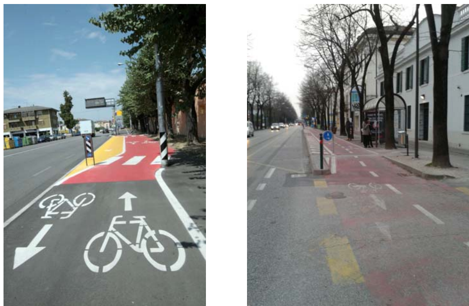
Figg. 24.2 – Esempi di interferenza tra fermata bus e percorso ciclabile
