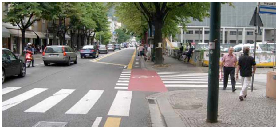
Fig. 23.1 – Esempio di corsia riservata ai velocipedi (larghezza 1 m) accanto ad una corsia riservata bus (3,5 m)
