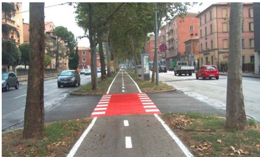
Fig. 29.2 Esempio di pista ciclabile in sede propria bidirezionale separata da aiuole verdi
