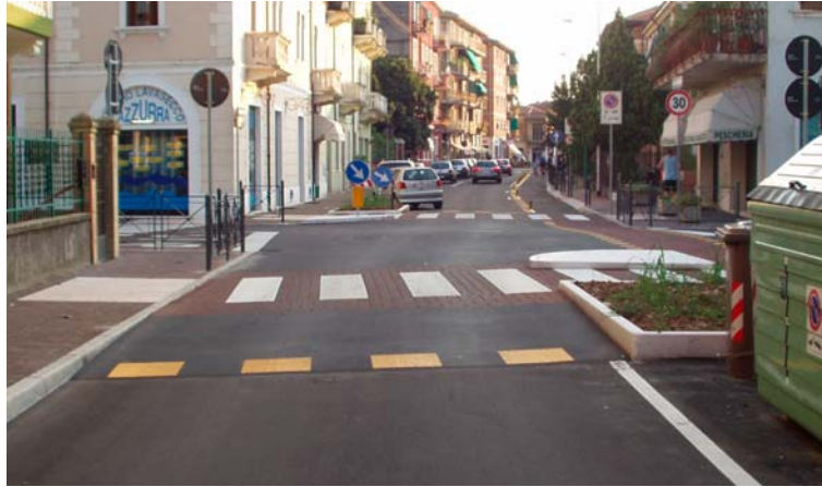
Fig. 26.7 Chicane realizzata con alternanza della sosta e contestuale piattaforma rialzata in bitume (Verona)
