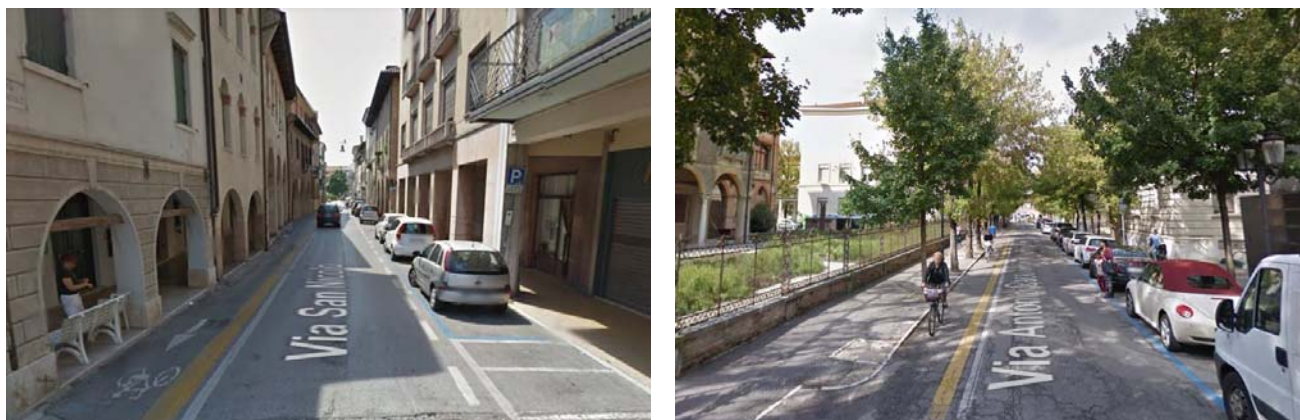
Fig. 29.9 Esempi di pista ciclabile con corsia riservata in direzione opposta a quella degli altri veicoli
