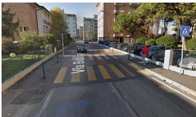
Fig. 26.3 Esempio di attraversamento pedonale rialzato
