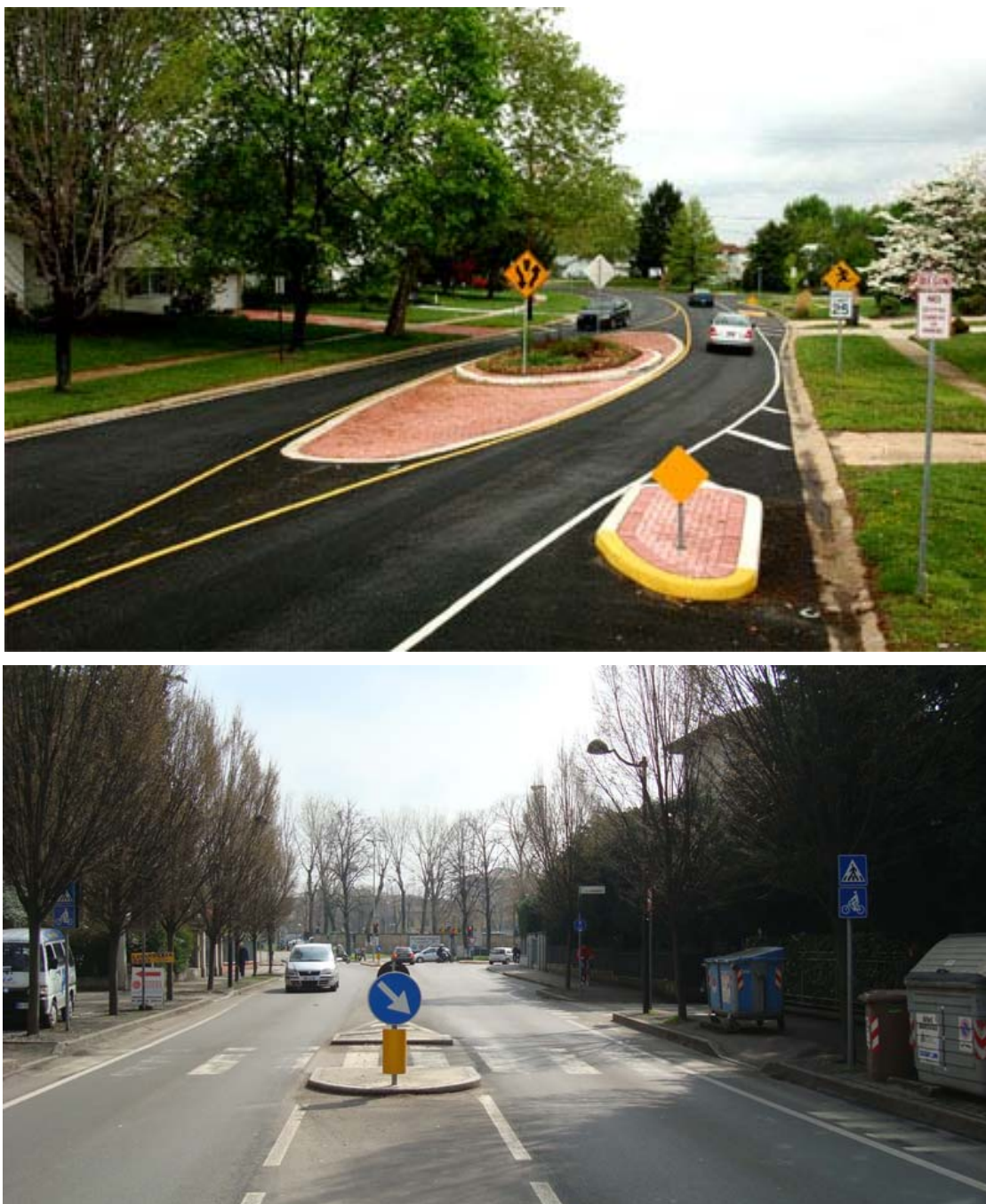
Figg. 26.15 Esempi di isole spartitraffico
