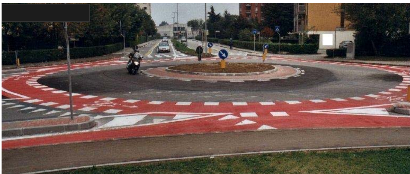
Fig. 20.3 – Esempio di banda ciclabile colorata all’anello e alle entrate e uscite
