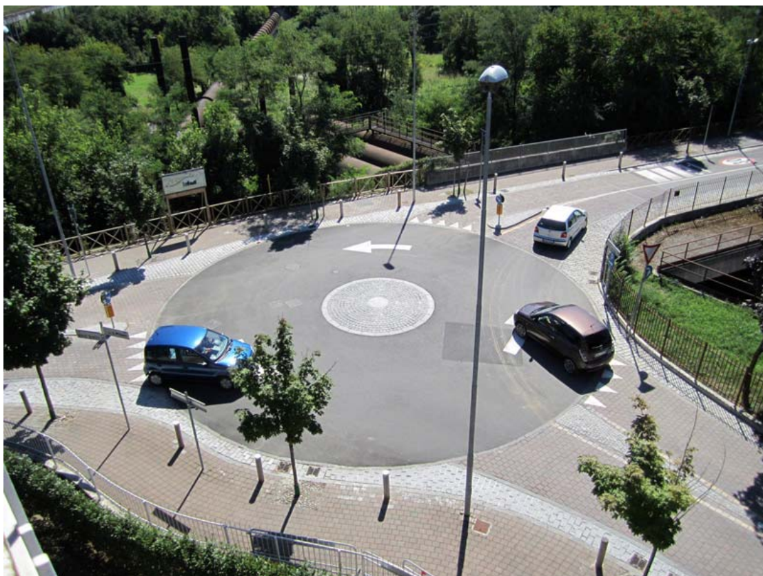
Fig. 26.16 Esempio di rotatoria completamente sormontabile. In questo caso la rotatoria ha interrotto un rettilineo e costituisce un intervento di moderazione del traffico
