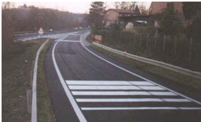
Fig. 26.1 Esempio di bande ottiche
