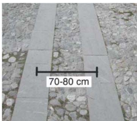
Fig. 27.2 Esempio di acciottolato con fasce di percorrenza
