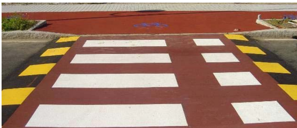
Fig. 30.3 Esempio di attraversamento ciclopedonale con leggera sopraelevazione
