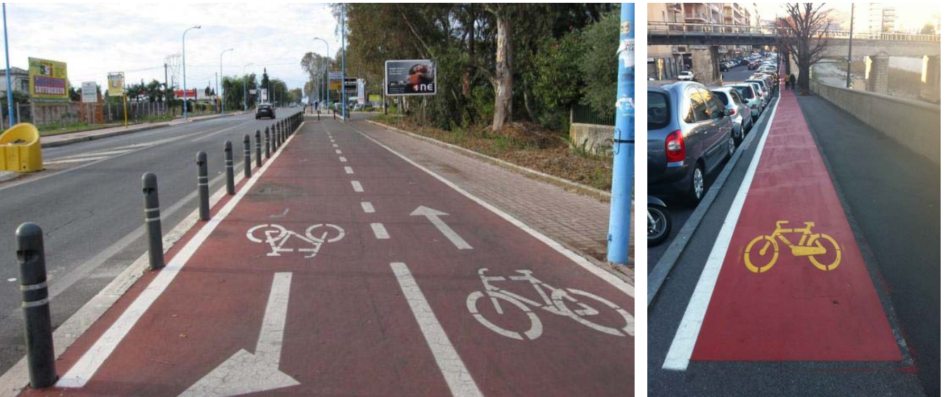
Fig. 29.3 Esempi di pista ciclabile in sede propria rialzata
